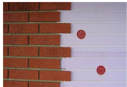
mit Fugenleitsystem schnell verlegt
