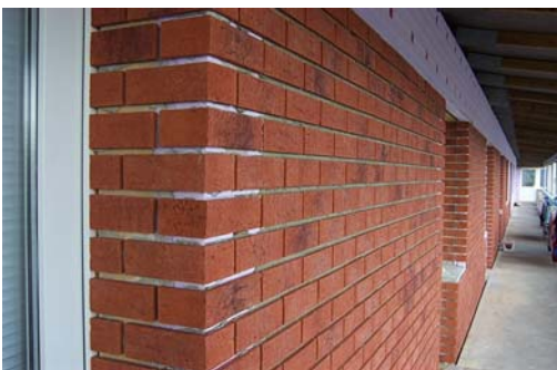
die Fensterleibungen, noch ohne Fugenmörtel
