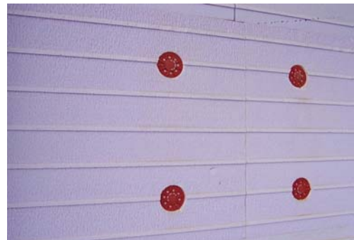
Dämmplatten fest verklebt und gedübelt
