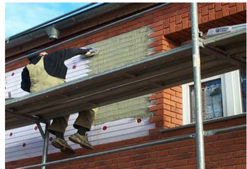
der Kleber wird aufgetragen
