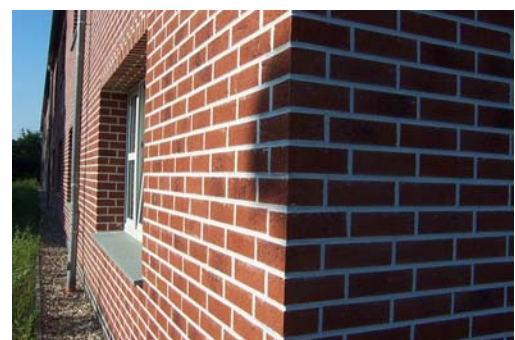
und fertig ist die neue Fassade
